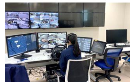
遠隔管制室(CRANTS内)
